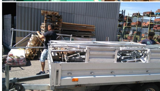
Quelle: Einsatz Dachdecker
